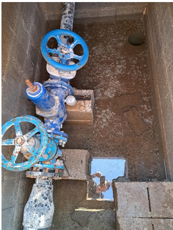
Slika 3.8: Nizvodni regulator tlaka za zonu Jug (Put Svetog Nikole)
