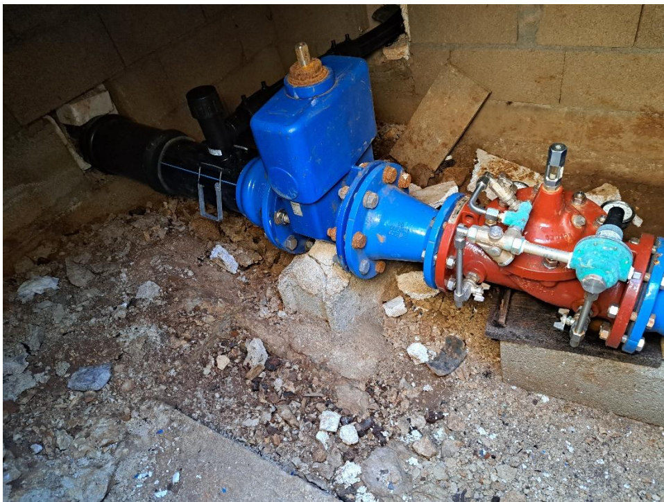
Slika 3.4: Regulator tlaka za nisku zonu Dubrovnik
