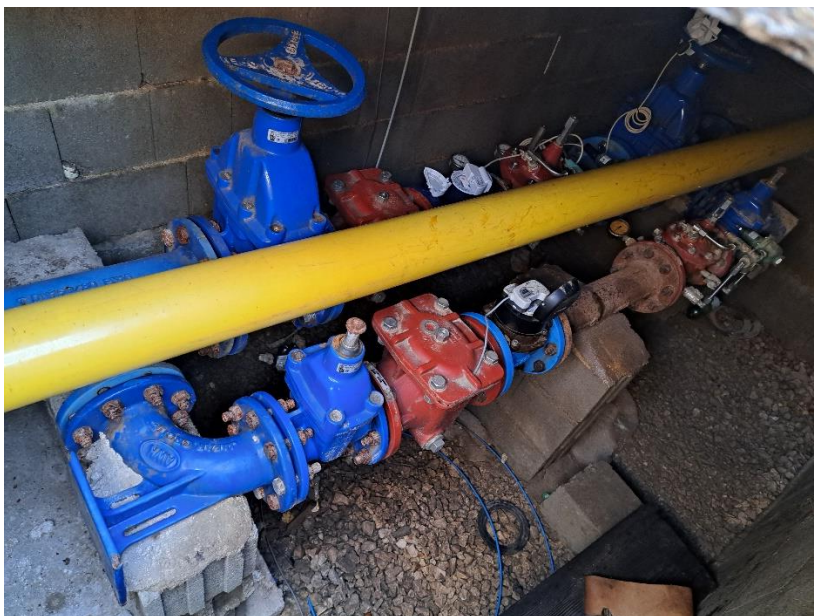
Slika 3.6: Uzvodni regulator tlaka za zonu Jug (Put Svetog Nikole)
